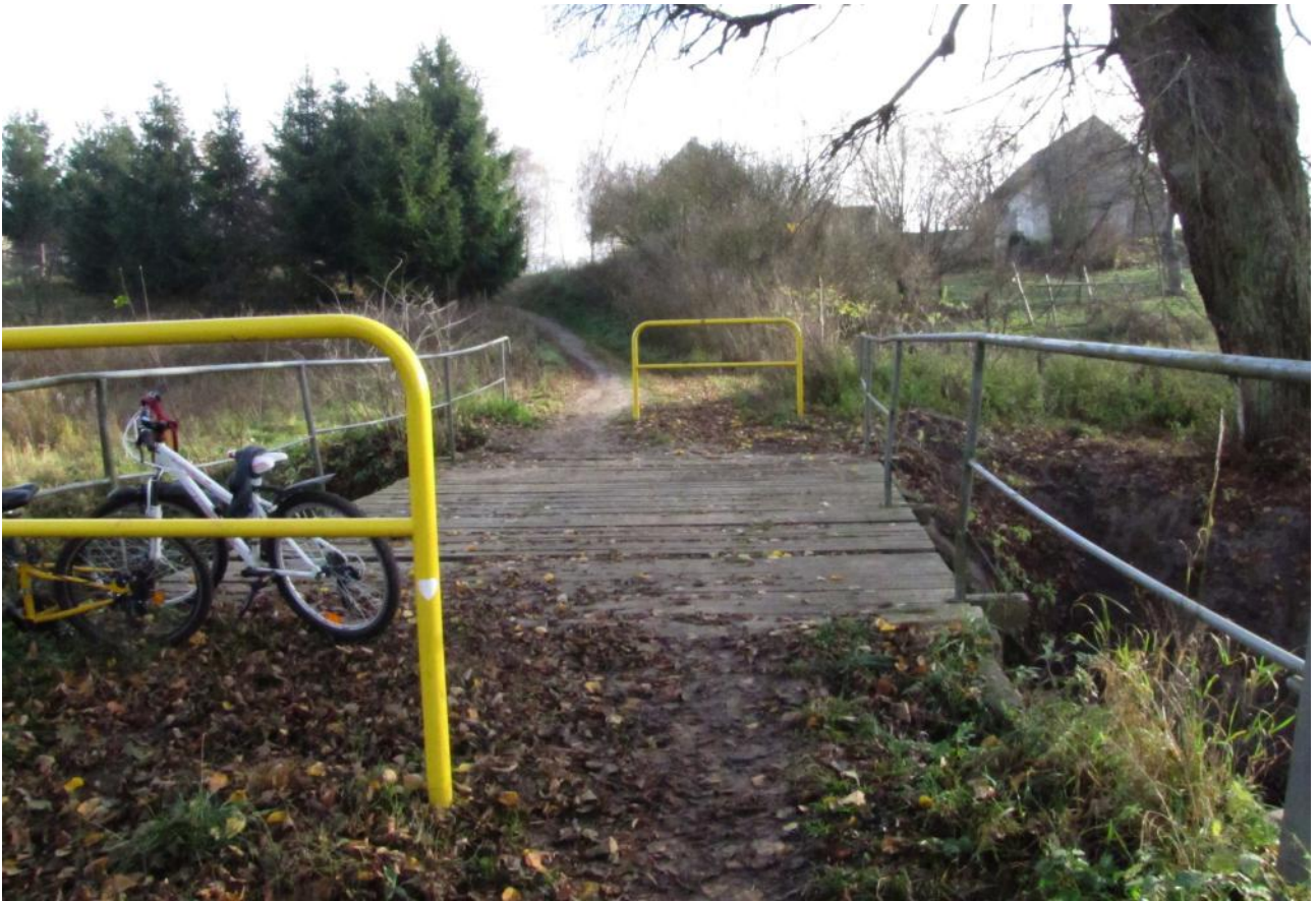
Fot. nr 76 . Pierwszy most . Ulica Boczna przy ujściu Oski .
