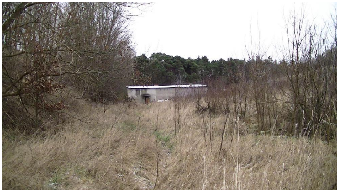
Fot. nr 17 . Isze Koryto Koło Nadleśnictwa odcinek bliższy szosie . W korycie wybudowany budynek gospodarczy . Rok 2018 .
