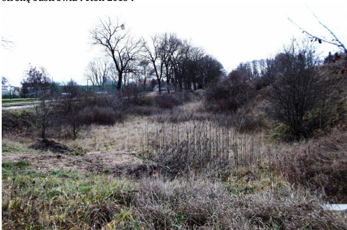
Fot . Nr 20 . Zbiornik nadmiarowy II-go koryta umiejscowiony pomiędzy torem kolejowym , a ulicą Kolejową . Zbiornik wypłycony przez piasek naniesiony ze żwirowni . Rok 2019 .
