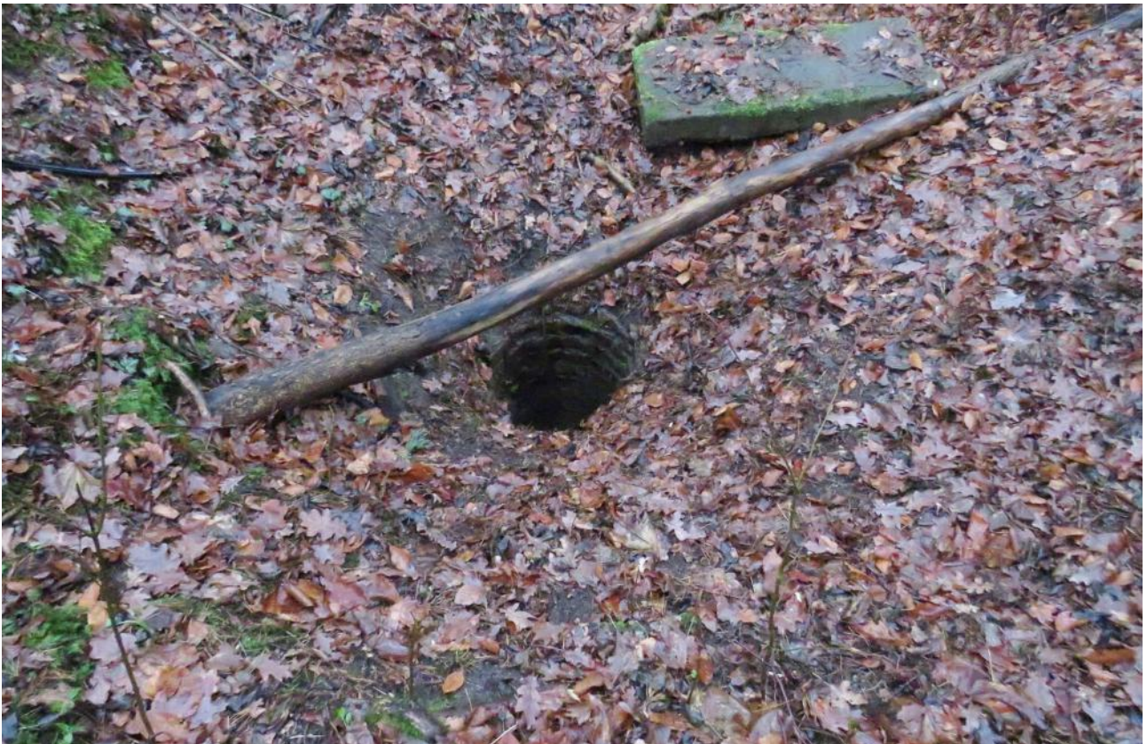
Fot. nr 12 . Otwór wentylacyjny tylnej komory . 2021 rok .
