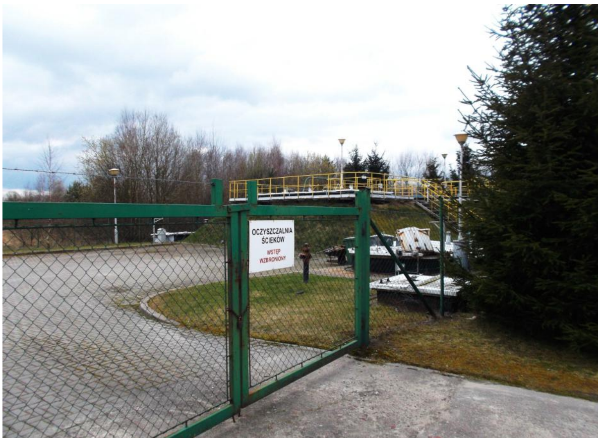
Fot. nr 25 . Oczyszczalnia ścieków Borucino .
