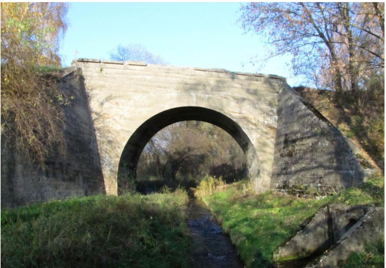
Fot. nr 81 . Most w nasypie kolejowym .
