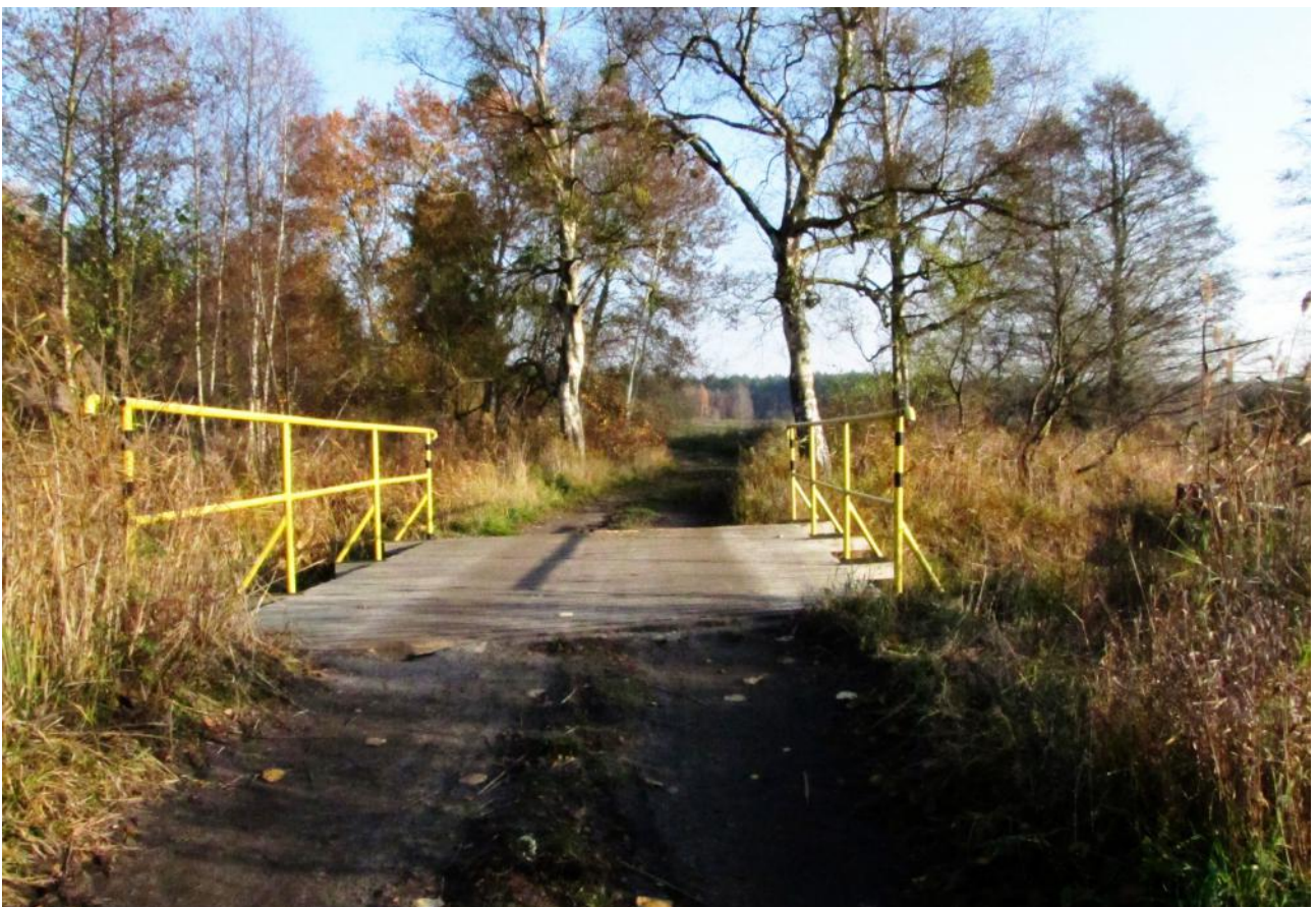
Fot. nr 83 . Most za stacją kolejową .
