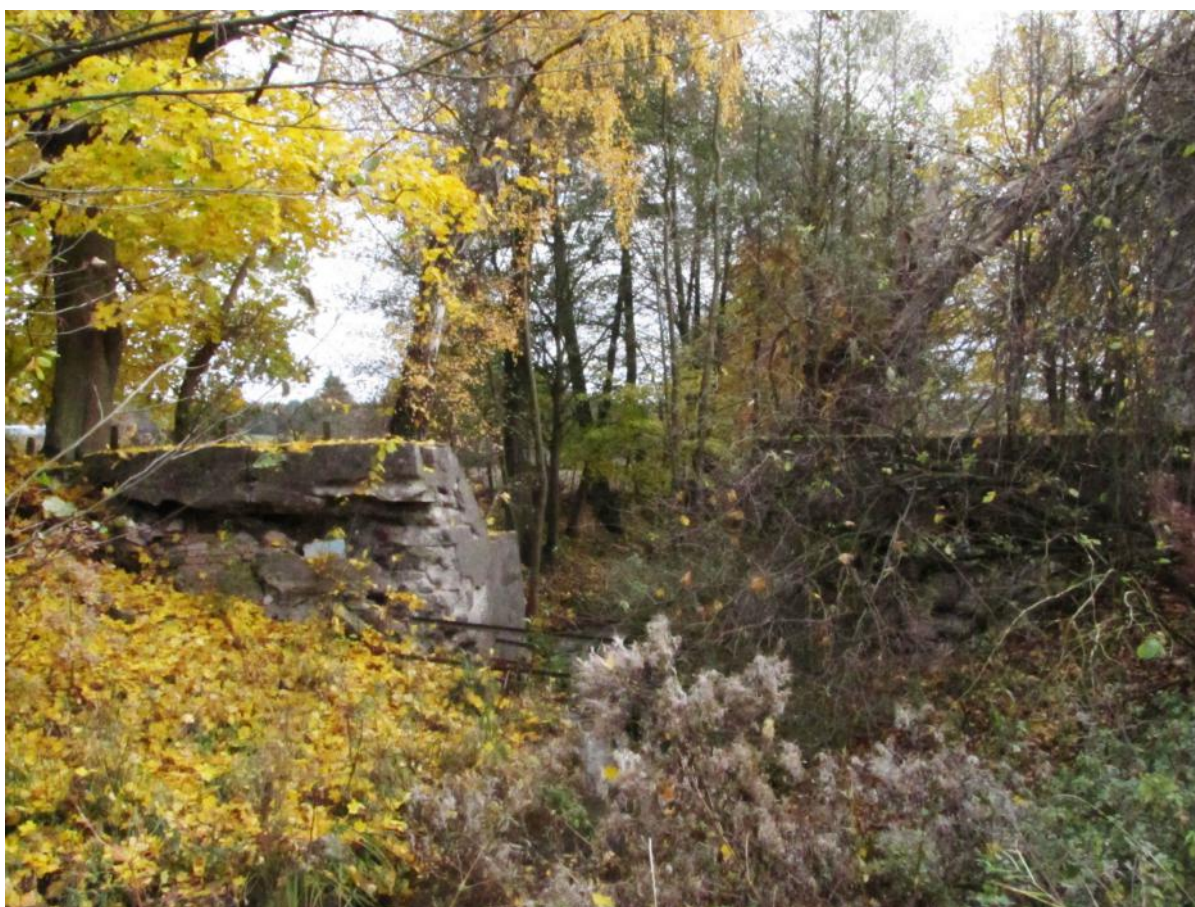
Fot. nr 32 . Tama młyna na Osce . Turbina zdemontowana . Rok 2018 .
