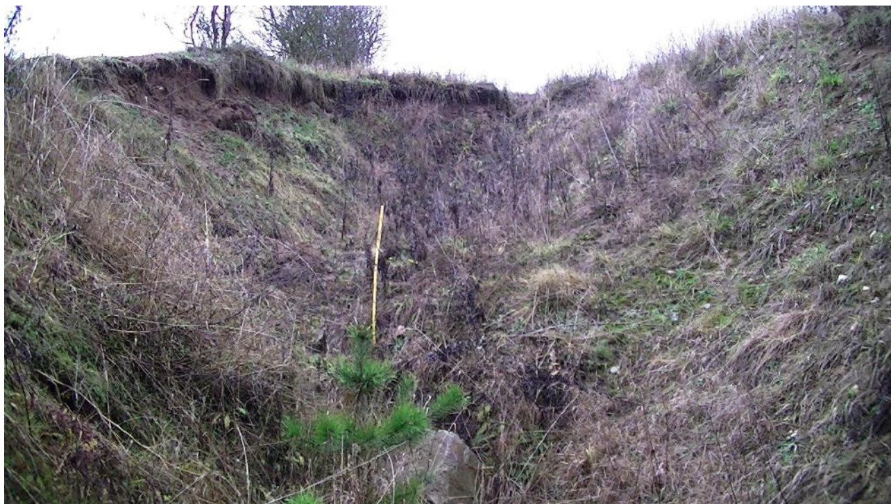
Fot. nr 5 . Koryto powstałe po dwóch ulewach . Żółta pionowa kreska to rozłożona miara 1 m . Rok 2019 .
