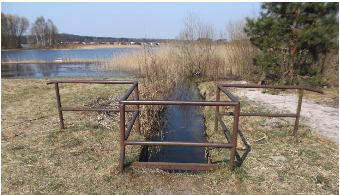
Fot. nr 61 . Początek kanału odprowadzającego nadmiar wód z jez. Kacko w wiosce .
