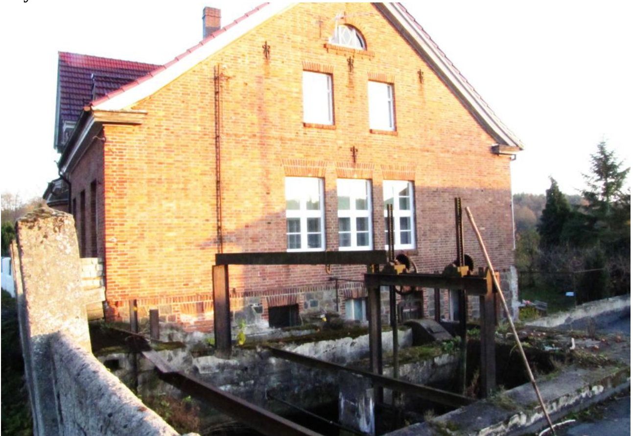
Fot. nr 87 . Urządzenia spiętrzające wodę Młynówki w Ptuszy przy trzecim moście .
