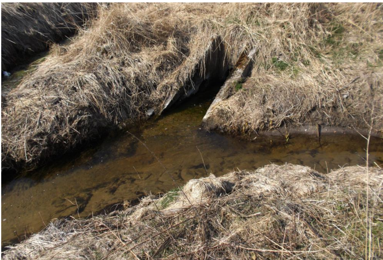
Fot. nr 110 . Ujście kanału z jeziora Kacko do Oski . Kierunek w lewo to kierunek w dół Oski . W dół Oski przedostała się nieliczna ławica płotek .
